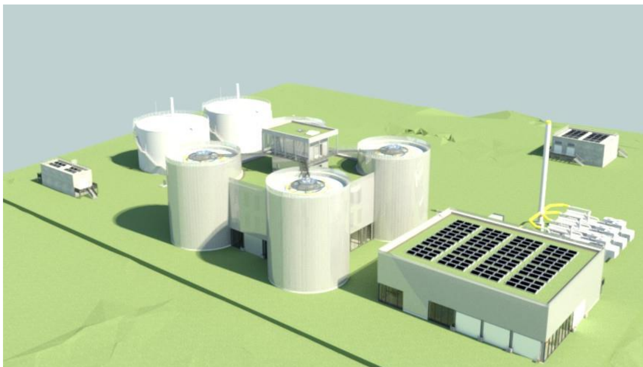
Abb. 1 von rechts nach links: MÜSE-Gebäude (maschinelle Überschussschlamm Eindickung), dahinter Energiezentrale mit Blockheizkraftwerken, links davon zentrales Technikgebäude mit vier Faultürmen, zwei runde Gasspeicher und neue 20kV-Übergabestation
