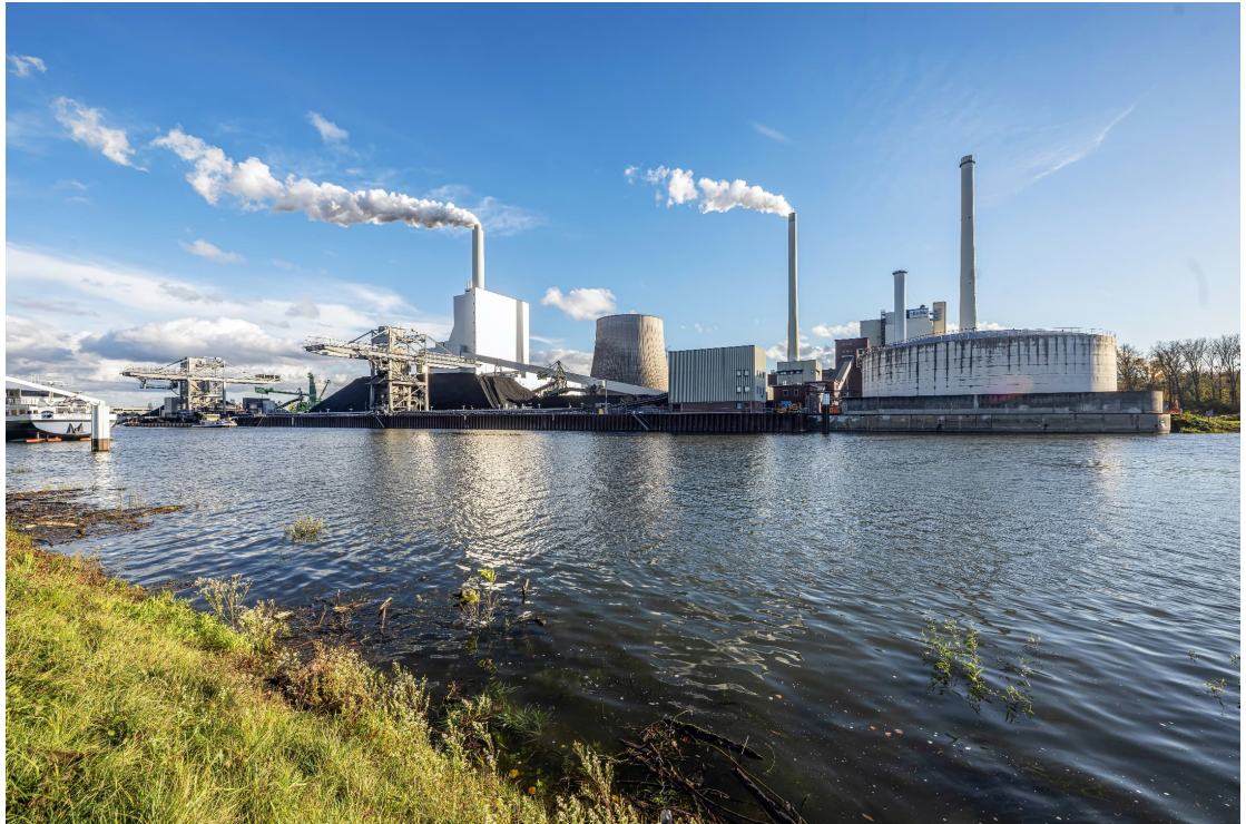
Abbildung 39. Sicht auf das bestehende RDK, Blickrichtung von Hafeneinfahrt bzw. von Nordwesten in Richtung Südosten. Quelle: EnBW
