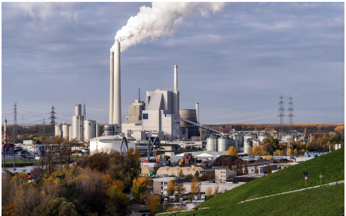
Abbildung 38. Sicht auf das bestehende RDK, Blickrichtung von der Deponie West (Energieberg) bzw. von Nordosten in Richtung Südwesten. Quelle: EnBW
