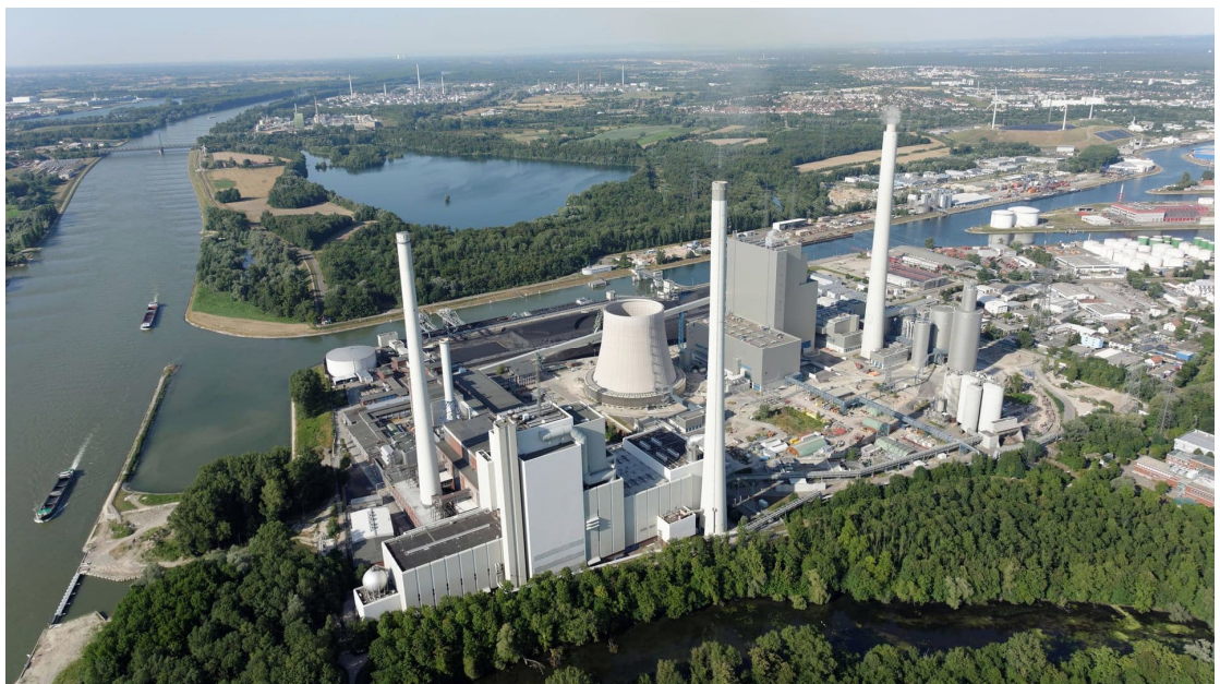
Abbildung 40. Sicht auf das bestehende RDK, Süden in Richtung Norden. Quelle: EnBW
