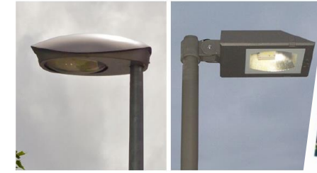
Optimale Leuchten: voll abgeschirmt, mit flache Schutzglas und waagrecht montiert
