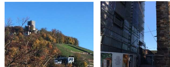
Der eingerüstete Turm mit elektrischem Aufzug
