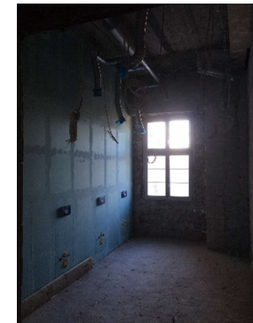
Rohbau mit Installationswand
