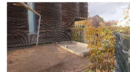
Fundamentplatte für Außenlager
