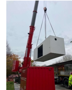
Anlieferung der Pelletheizungs - Container per Kran
