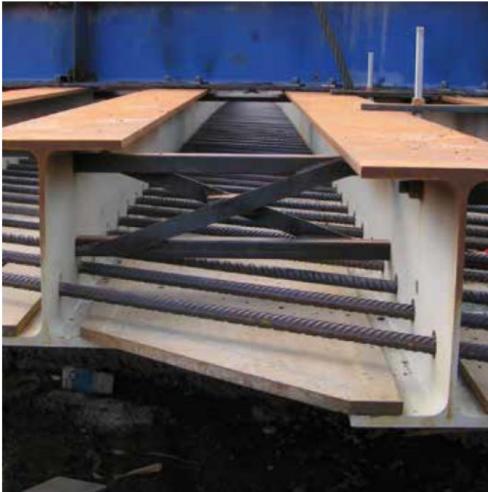
vor der Betonage
