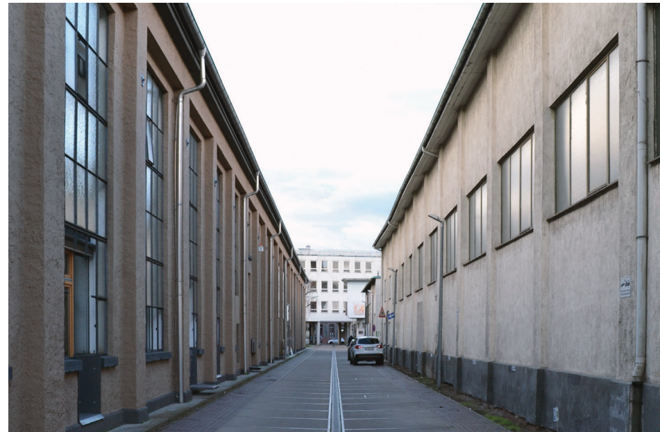
Bestand mit umgenutzter Nachbarhalle
