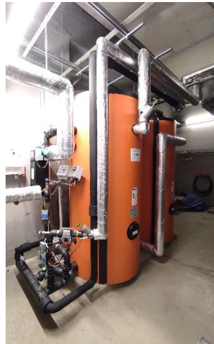
neue Warmwasserbereitung
