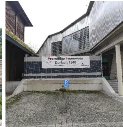
Sichtschutz ehemaliges „Dreckeck“
