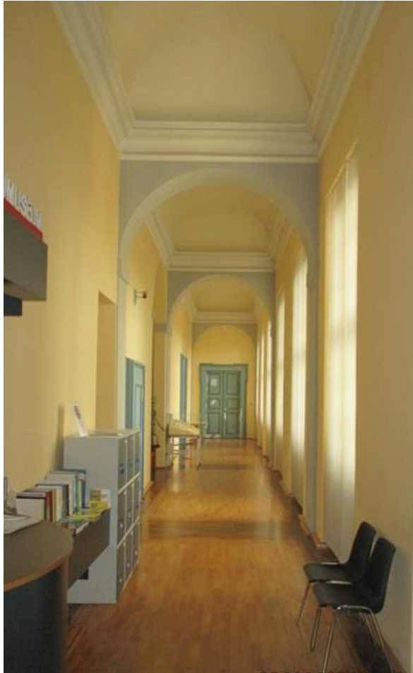
Flur im Bereich Pfinzgaumuseum - vorher
