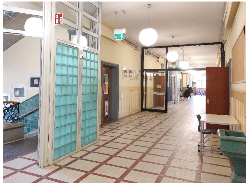
Pestalozzischule Flur-Abtrennungen nachher abschließende Arbeiten Fastnacht 2021
