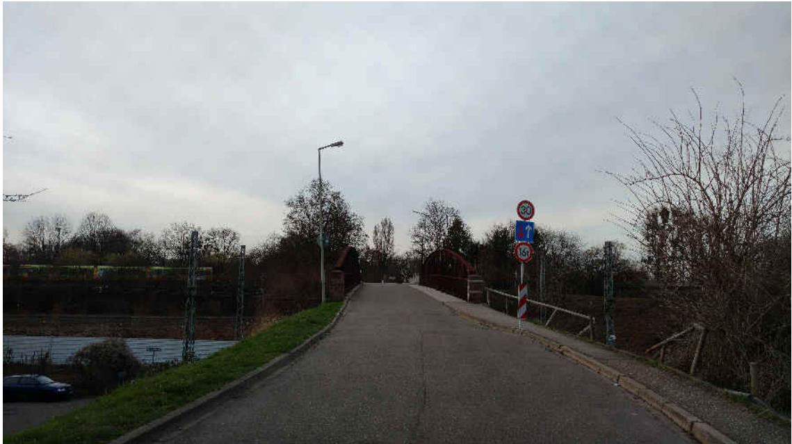
Abbildung 16: Östlicher Bereich, Querung Bahnstrecke nach Pforzheim
