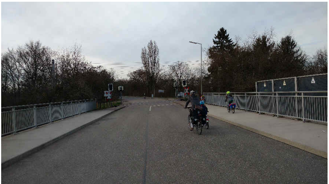
Abbildung 15: Mittlerer Bereich, Querung DB-Hauptstrecke Karlsruhe - Heidelberg
