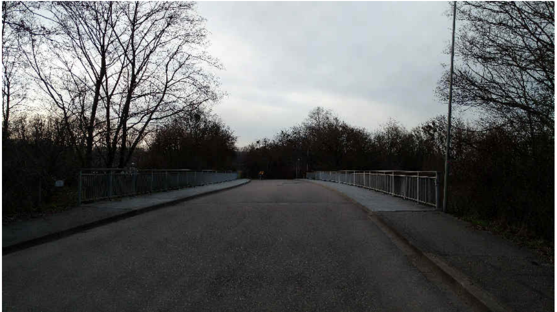
Abbildung 14: Westlicher Bereich, Querung K9659
