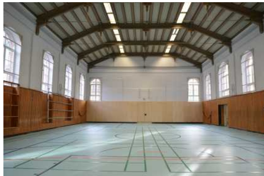
Sanierung Turnhalle nachher
