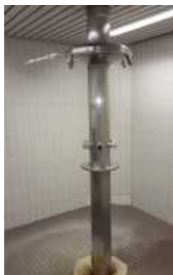
Sanierung Duschen vorher
