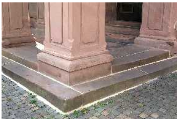
Stufen neu gesetzt
