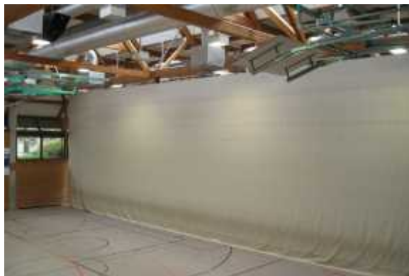
Sanierung Trennvorhang vorher
