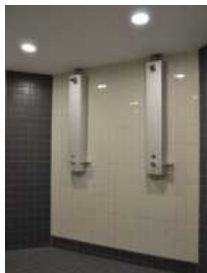
Sanierung Duschen nachher
