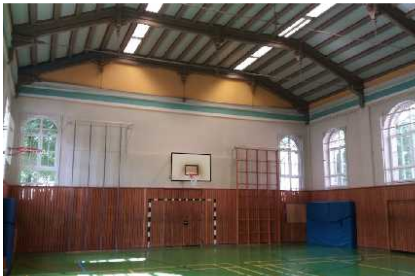
Sanierung Turnhalle vorher
