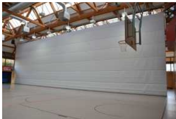
Sanierung Trennvorhang nachher
