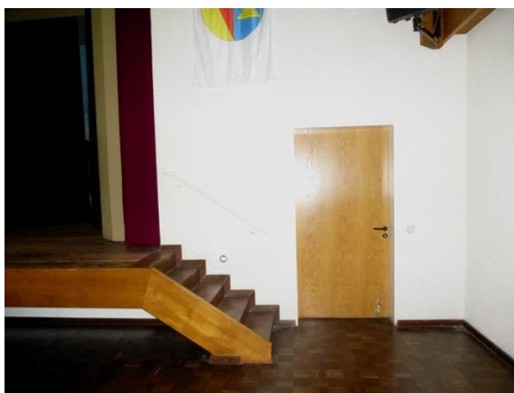
rechter Bühnenzugang , hier könnte der Plattformlift platziert werden
