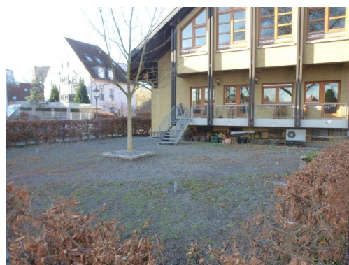
Ansicht Biergarten von Osten, jetziger Zustand
